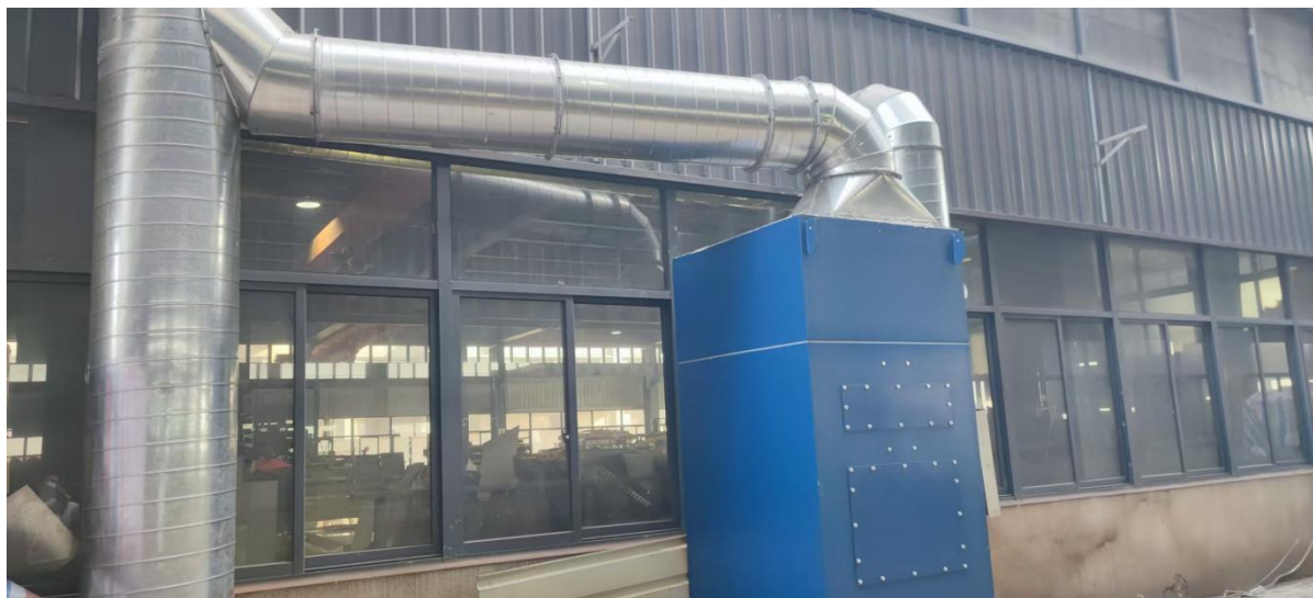
激光切割烟尘废气处理设施
