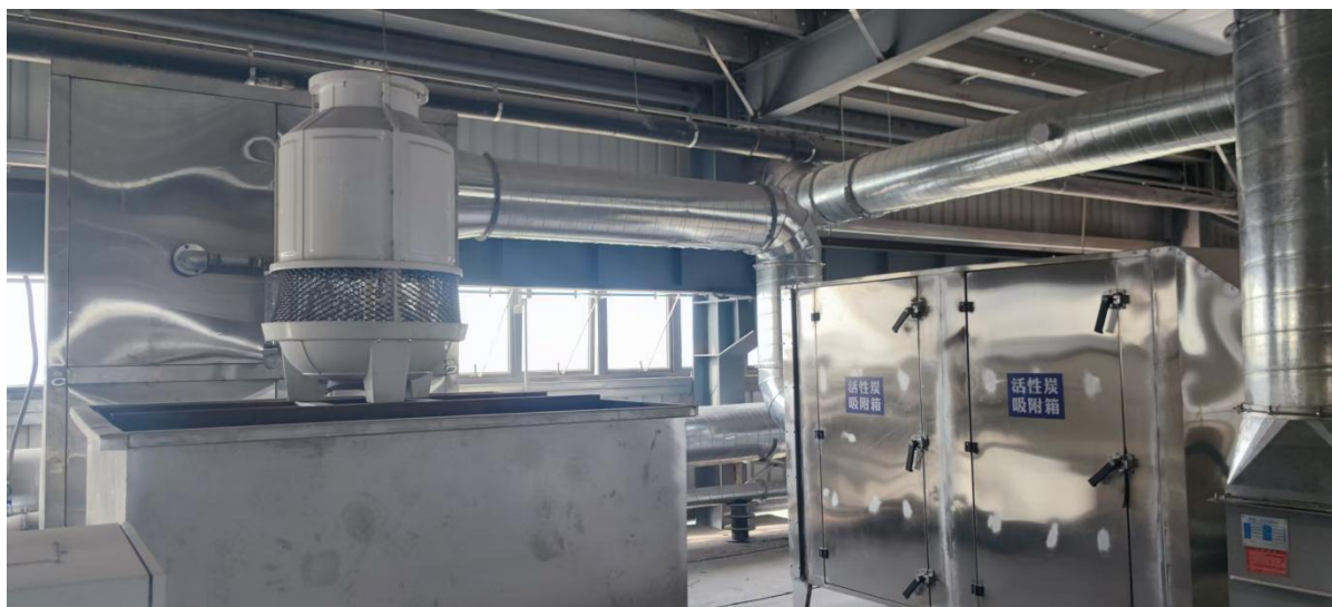
塑粉固化、天然气燃烧废气处理设施
