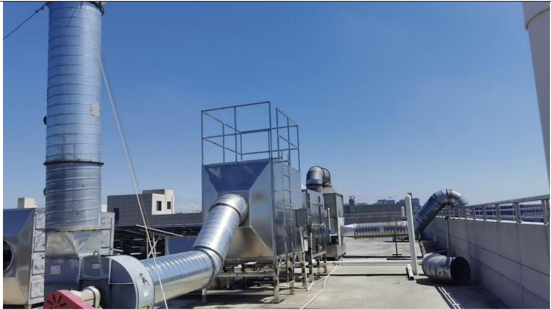
喷漆废气处理设施
