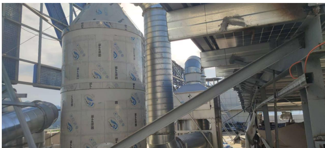
水性漆浸漆废气处理设施及排放口
