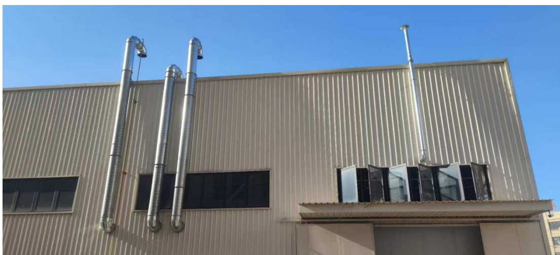
切割粉尘（左）、喷塑线固化废气 1（中）、天然气燃烧废气 1（右）出口
