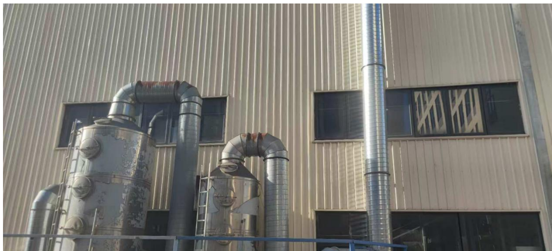
水性漆喷漆废气处理设施及排放口
