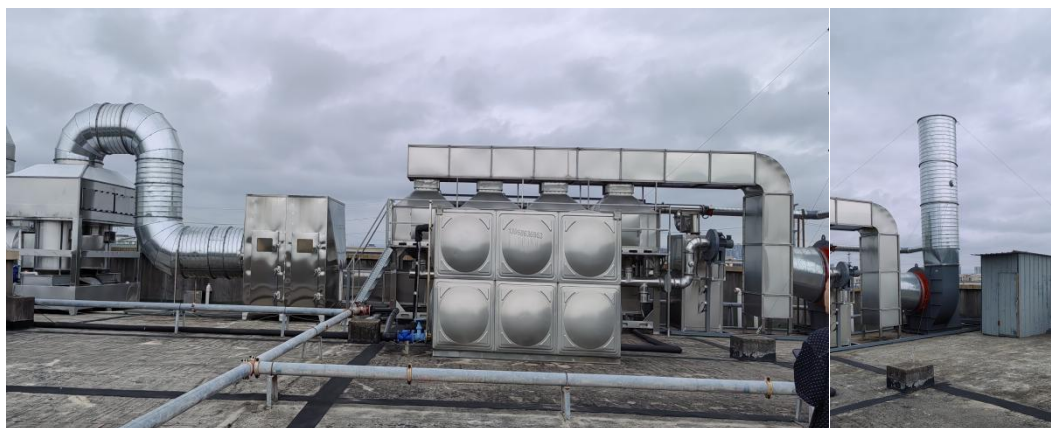
罩光漆喷漆废气处理设施
