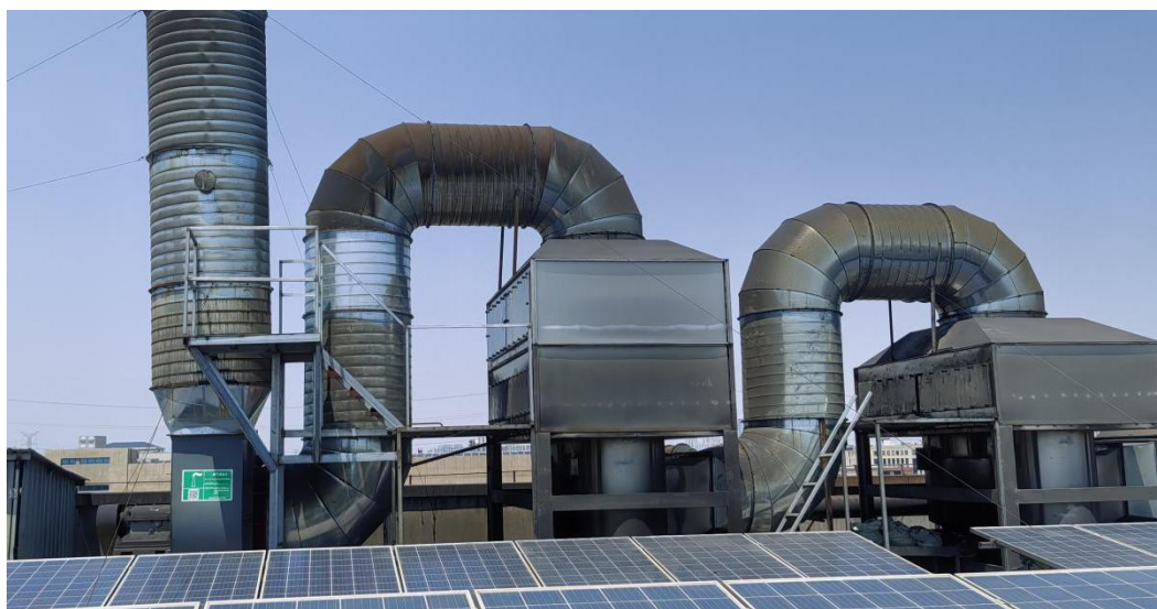
2#水性喷漆废气处理设施
