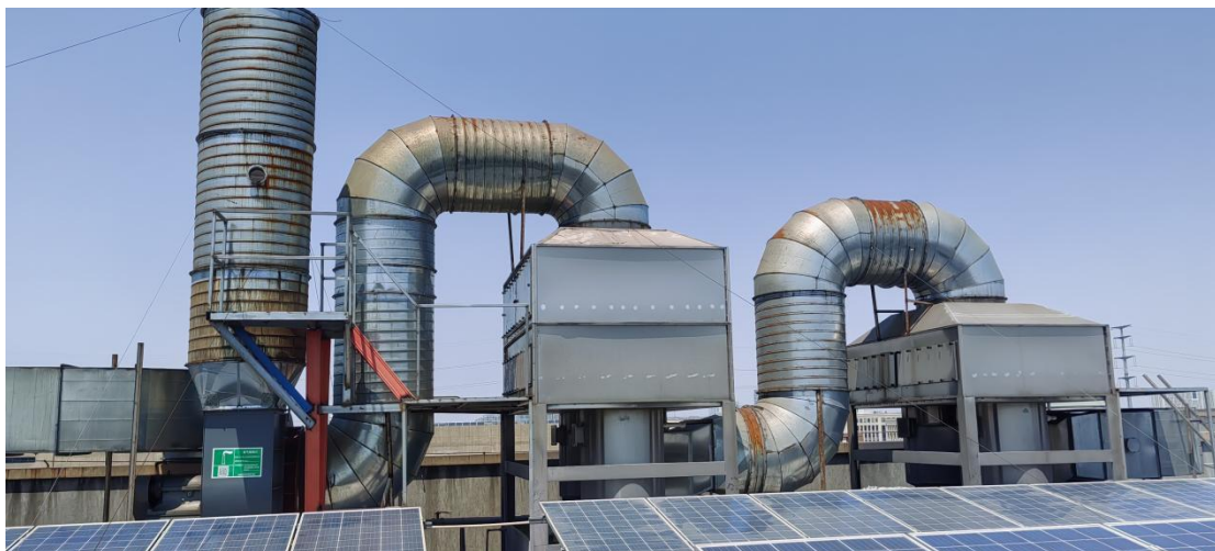
1#水性喷漆废气处理设施
